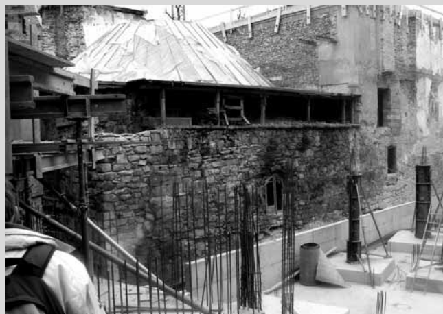
A Rác-fürdő rekonstrukció közben
