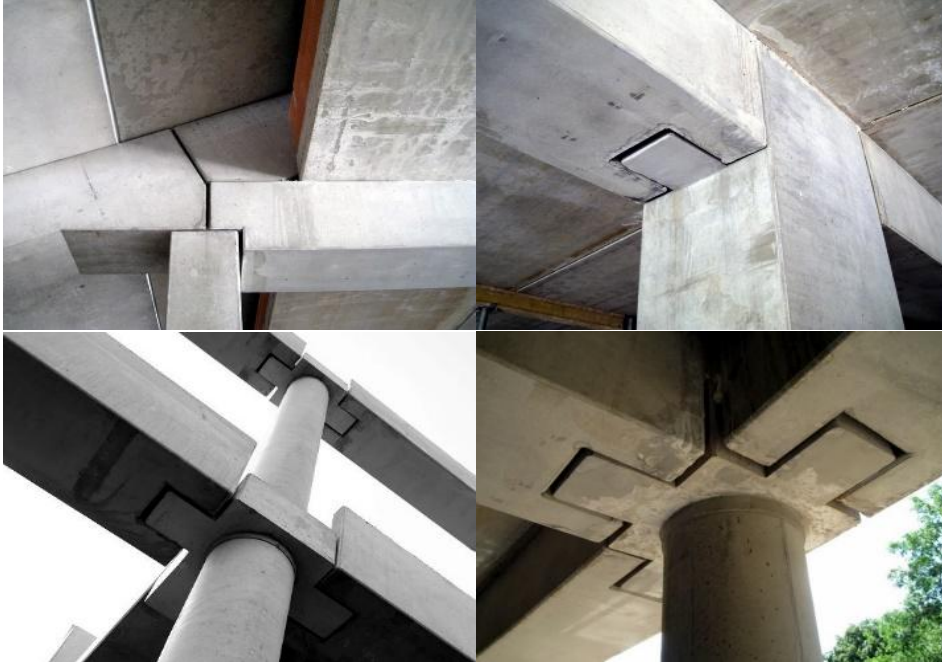
3. ábra. Előre gyártott vasbeton elemek kapcsolatai
