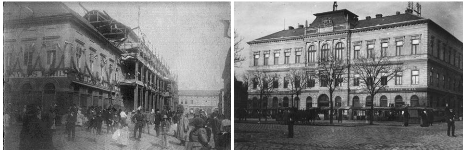
A Tisza-palota emeletráépítés alatt és készen
