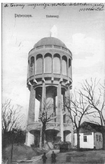
A Leveles-csárda mellett felépült nagyerdei víztorny
