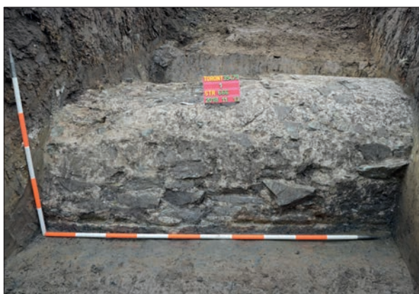
10. ábra. A vízvezeték külső vízzáró réteggel ellátott, intakt szakasza Figure 10. Intact section of the aqueduct with watertight enclosure
