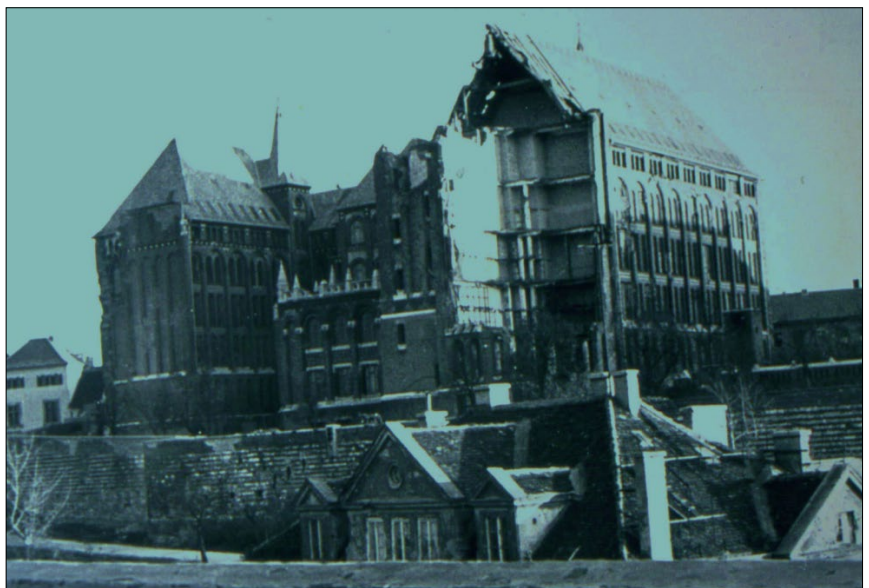
1–2. kép –Ég a levéltár – és ami az épületből megmaradt
