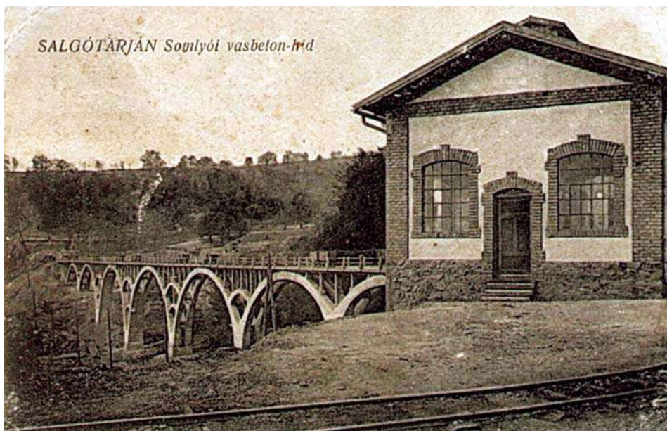
3. ábra - Somlyói vasbetonhíd
