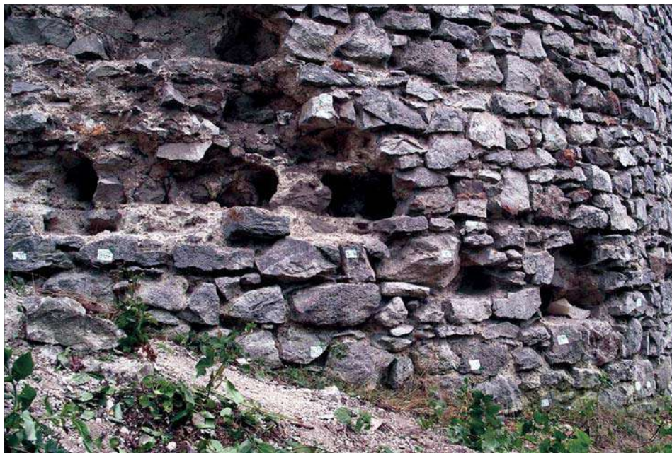
17. ábra Az északi falmaradvány külső falsíkja falkötő gerendák helyével Outer surface of the north wall with the hole of timbers
