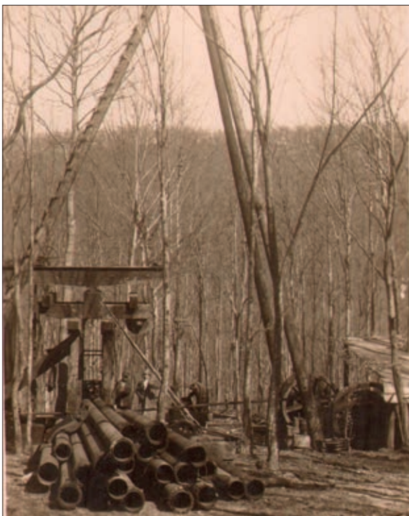
18. ábra: Fauck-fűrőberendezés: háttérben a fűrőtorony (háromláb), előtte béléscsővek, jobboldalt pedig a berendezést meghajtó gőzgép (Dornay Béla Múzeum, 547 sz. fénykép).
