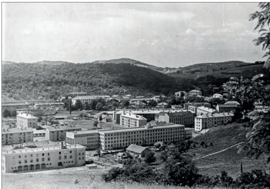
5. kép: Az épülő vásártéri lakótelep keleti irányból, 1955
