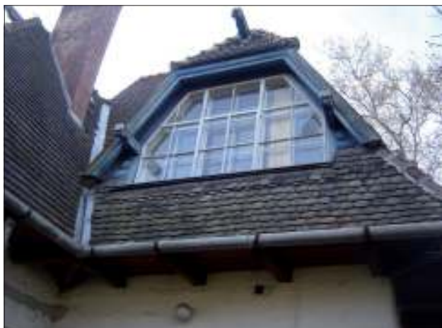
3. kép: A műterem ablaka, faragott gerendavégekkel Image 3: La fenêtre de l'atelier, avec des bouts de poutre sculptés
