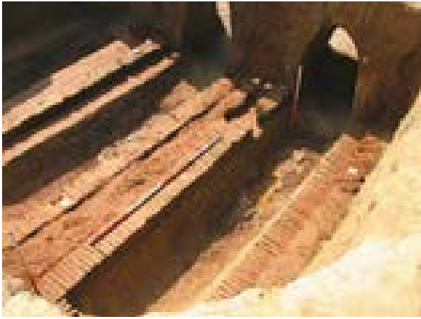
25. kép. Halszálka/parkettamintába rakott középső rész a 2-3. nyílás közötti tűzpadon
