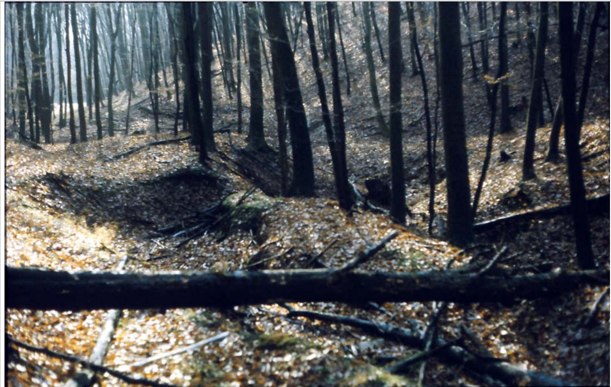
14. ábra Töltések és gátak maradványai a patak völgyben
