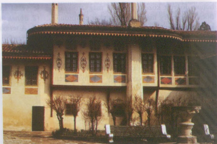
3. ábra. A Kánok palotájának épületrésze. Fotók: Solymosi Péter
