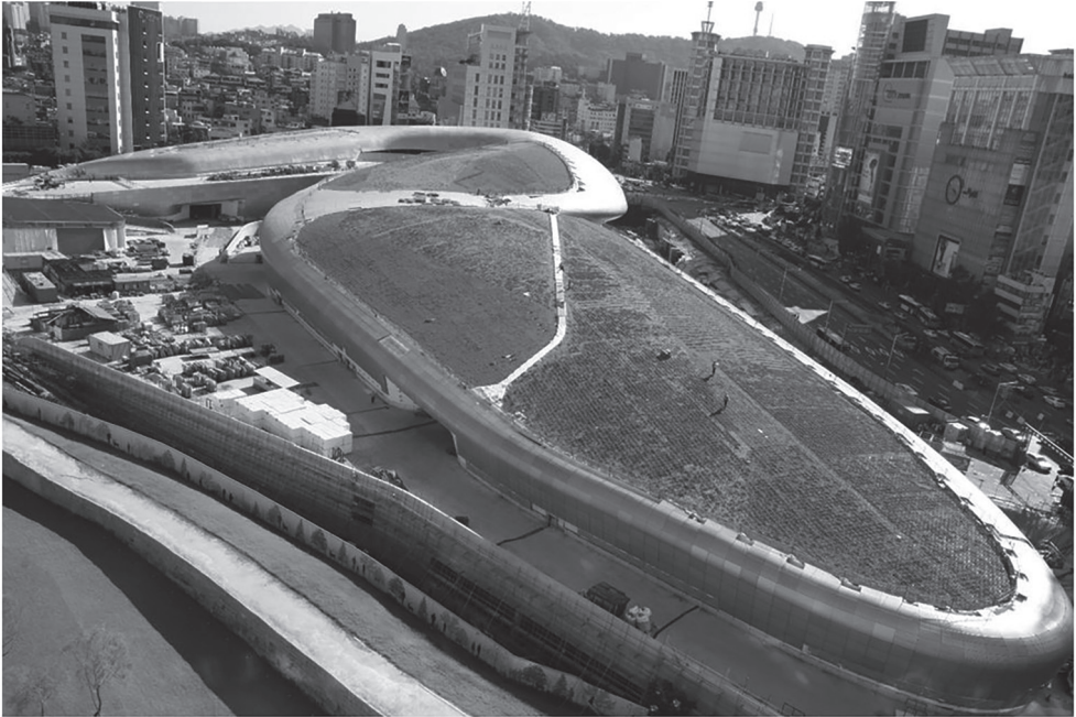
1. kép: Szöul Dongdaemun Design Plaza, a teljes tető, 20 000 m 2 zöld felületet kapott (BRM, Building & Roof Management, Firestone UltraPly TPO)
