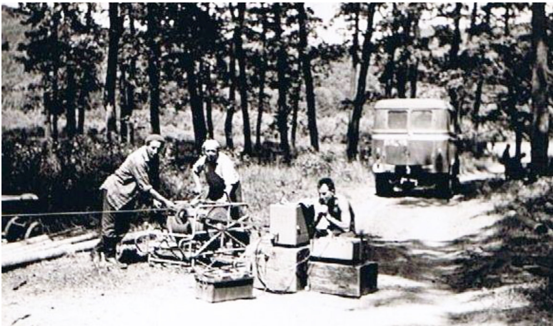
Egy GMG-12 hordozható berendezéssel végzett, 1964-es tardonai barnakőszén-kutató szelvényezés. Bucsi Szabó László (jobb oldalon) operátori munkáját Szalonna Mihály és Csordás János (balra) segítették
