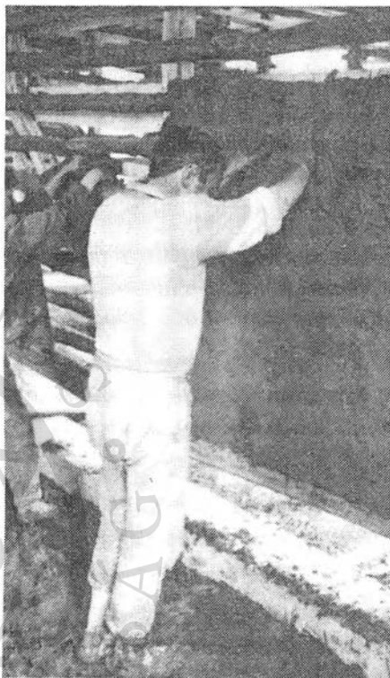
Az épülő ház falának tapasztása. Csík 1993. Fotó: Fosztó László
