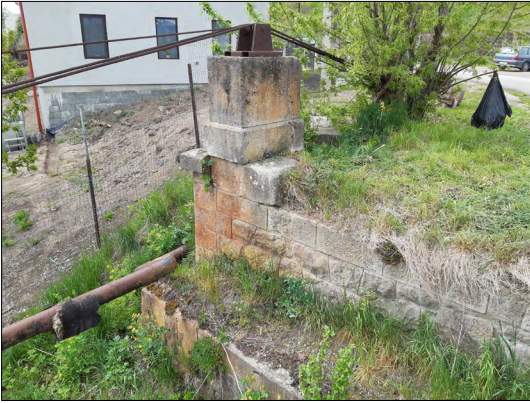
2. ábra. A híd fő jelenlegi állapotában
