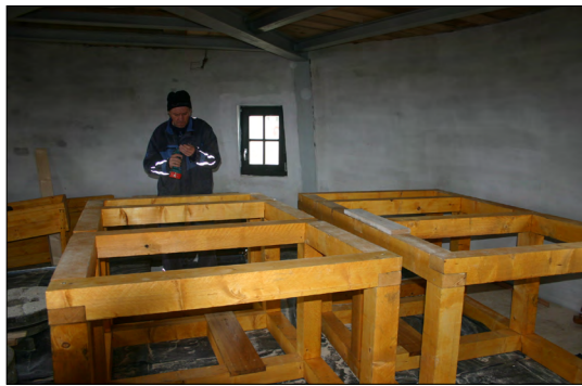
10. ábra. A malomgépezet tartószerkezetének össze-szerelése
