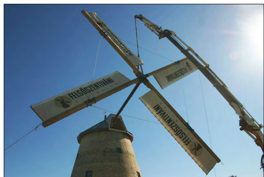
6. ábra. A szélkerék felemelése, helyretétele
