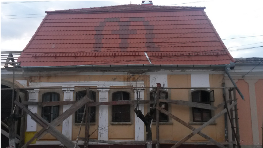
6. ábra. Szamosújvár–zarándokszállás és plébánia – építkezés
