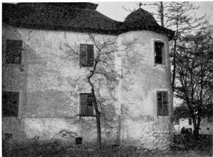
2. Kéked: Melzer kastély észak-keleti szárny
