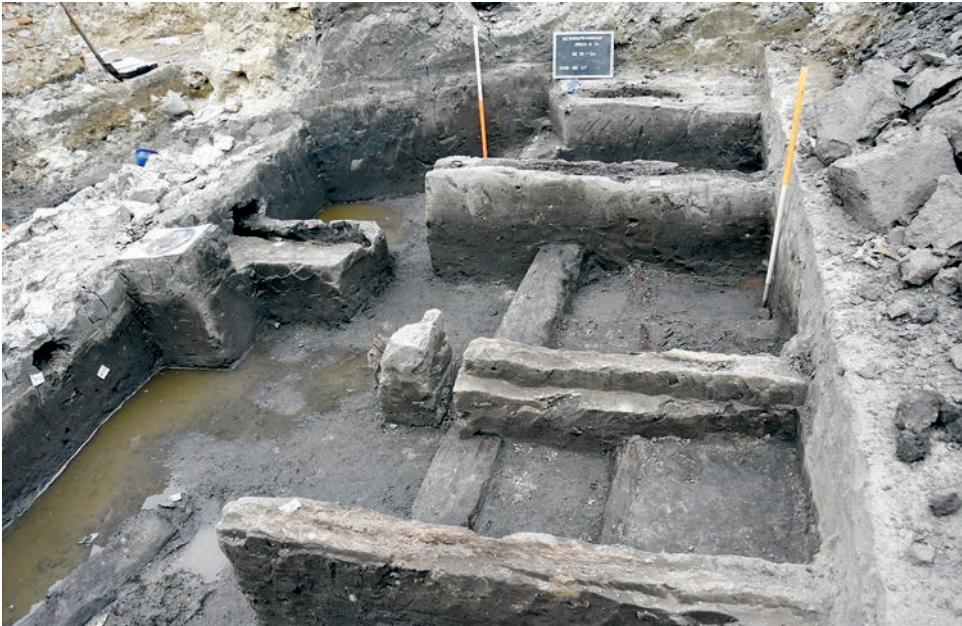
13. kép: A kőerődítés alapozási szerkezetéből (baloldalon) a belső földtöltés szerkezete felé induló gerendák és a földtöltés szerkezetének (jobb oldalon) magasabban fekvő gerendái kivétel nélkül elkorhadtak
