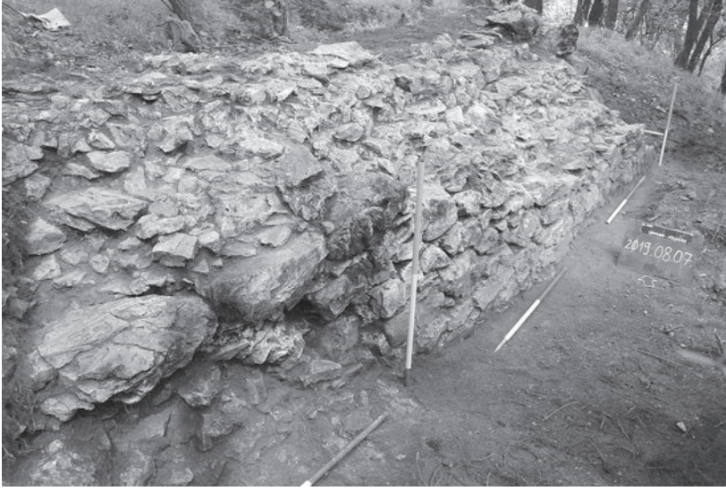
3. kép: A romtisztítás során kibontott falszakasz D-ről fotózva
