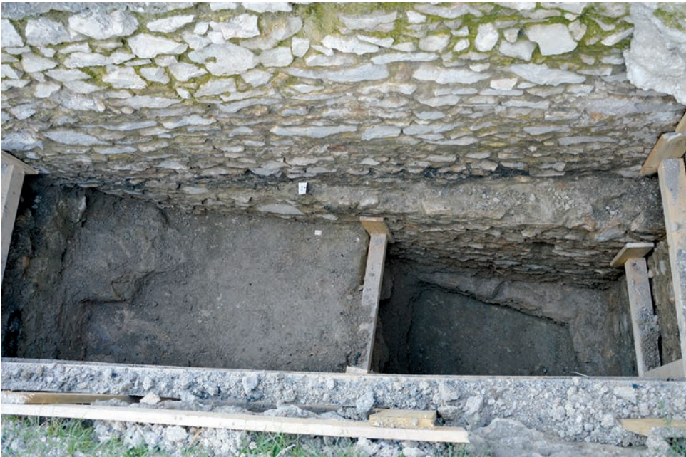
5. kép: A falszoros külső falának alapozási szerkezete
