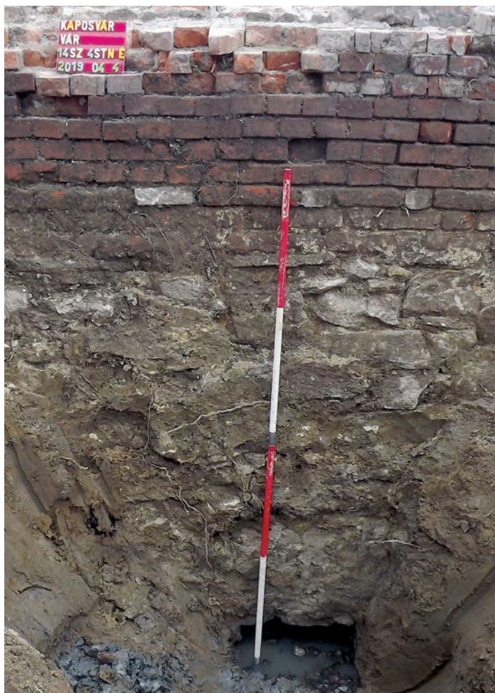
8. kép: A torony alapozása (A felmenő fal tégláinak egy része újabb ráfalazás)
