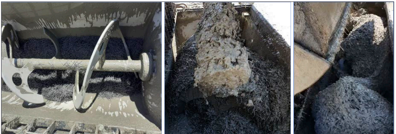
27-29. ábra: A Bobcat munkagép keverőadapterével gyorsan homogenizálható a 125 kg/m 3 acélszál
