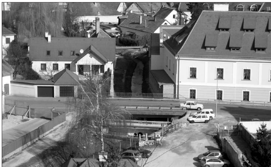
Jókai utcai híd
