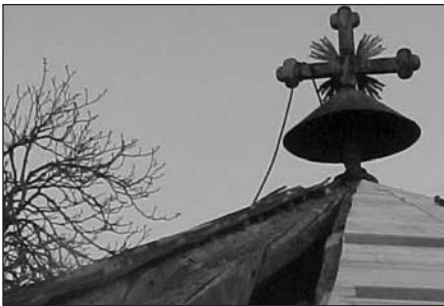
A kereszt javítása: leemeltük a rézlemez keresztet a tartó rúdról
