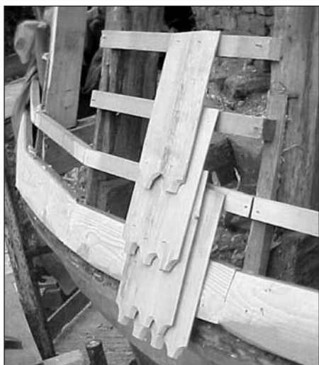
Minta zsindely felület, itt határoztuk meg a léckiosztást
