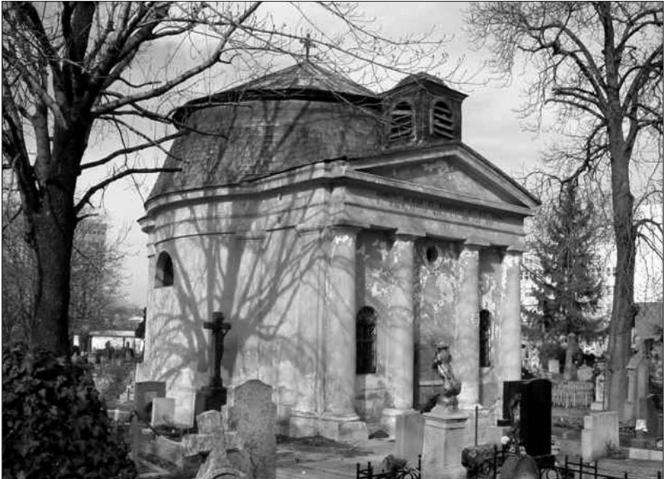
Kápolna a felújítás előtt (sárga)
