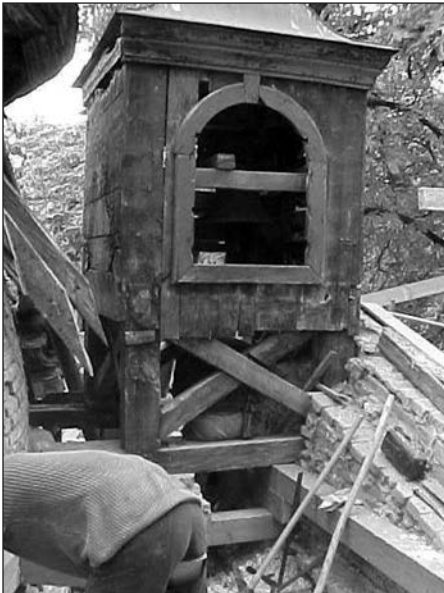
A fiatorony, csak a keményfaszerkezet volt ép, a deszkázatot cserélni kellett
