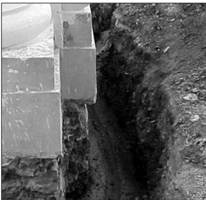
Szivárgó rendszer készül a további nedvesedés megakadályozásához
