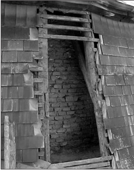
A megbontott tető, itt kezdtük a feltárást és a felújítást
