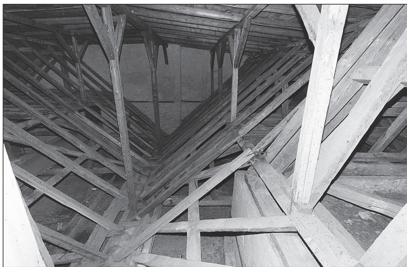
A manzárd fedésűvé átalakított két barokk ároktető csatlakozása. (Fotó: Hack Róbert)
