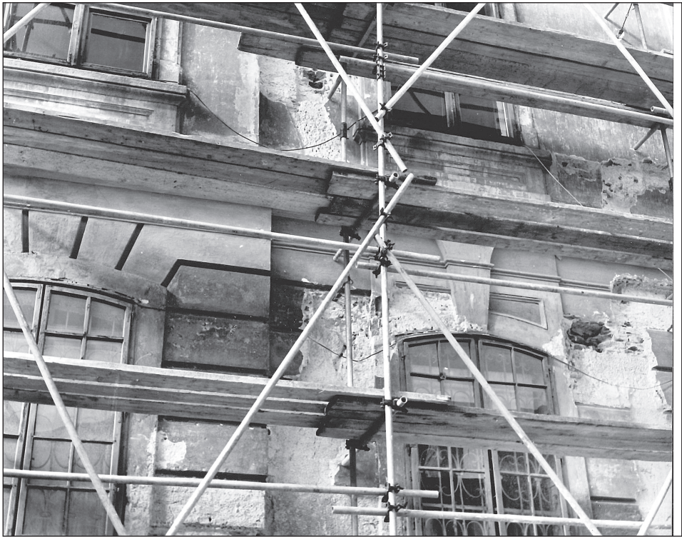
A palota déli homlokzatának részlete a korábbi homlokzatarchitektúra maradványaival. (Fotó: Koppány Tibor; MÉM MDK Fotótár ltsz. 110.362)
