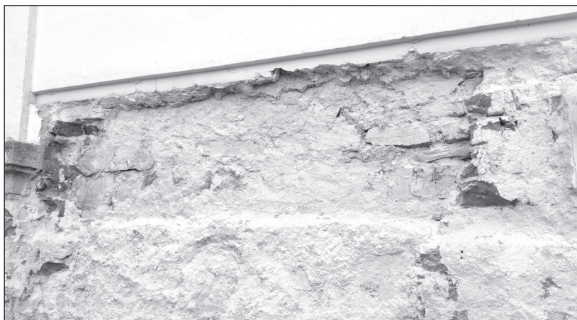
Keleti homlokzat. A 3. és 4. ablak könyöklőjéhez tartozó kifalazások a második barokk periódushoz tartoznak, az Acsády épület mélyebb falsíkját igazították a kívánt síkra. A korábbi falmező faszénnel kevert hóbörcsös mészvakolat rétege látható a későbbi barokk és XX. századi rétegek alatt. (Fotó: G. Lászy Judit)
