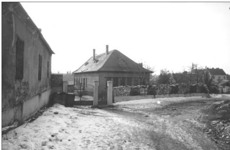
Az iskola épülete az 1950-es évek elején. A kerítés hiányzó részeit a bombázások során megsemmisült kőépületek törmelékeivel rakták be. Fotó archív
