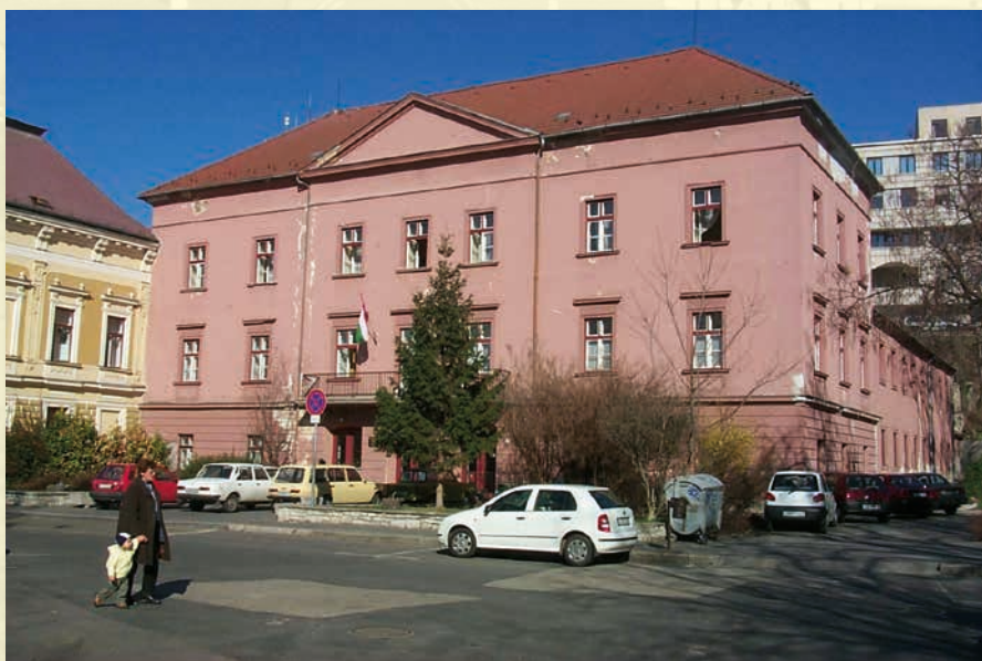
A CSERMÁK ANTAL ZENEISKOLA ÉPÜLETE A 2015-ÖS FELÚJÍTÁS ELŐTT
