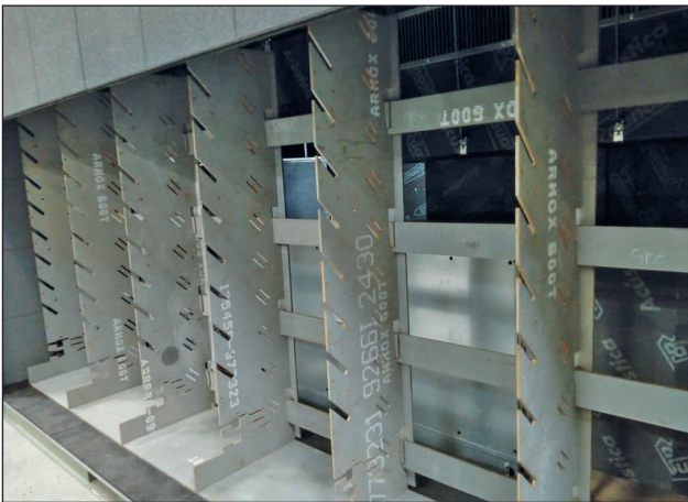
9. ábra. A lövedécsapda beépítés közben (Fotó: Bimbó István)
