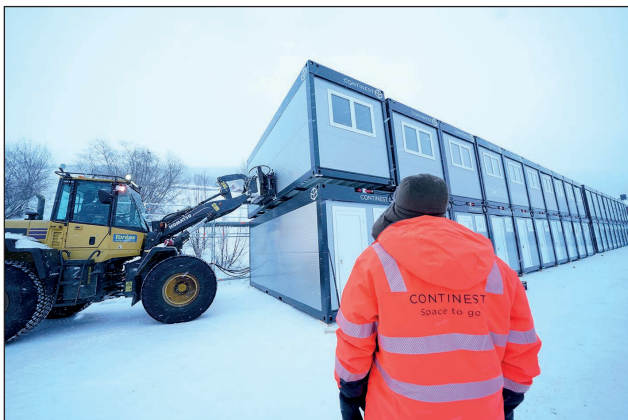
16. ábra. A konténerek a sátrakkal szemben függőlegesen bővíthetők, így kisebb alapterületen nagyobb élet- és munkatér biztosítható (Forrás: Continecst Technologies Zrt.)
