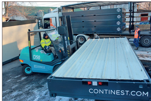
10. ábra. A telepítés 2. fázisa. A szállítójárműről az összecukott konténer emelőgéppel helyezik a telepítési helyére (Forrás: Continecst Technologies Zrt.)
