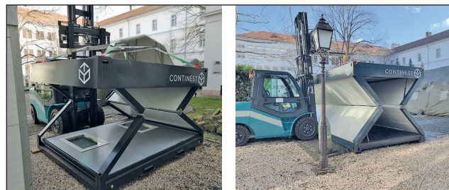
11. ábra. A telepítés 3. fázisa. Egy konténer felállításához 2 fő kézi emelővel; targonca vagy daru szükséges (Forrás: Continecst Technologies Zrt.)
