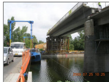
17. ábra Az endrődi Hármaskörös-híd bontás közben
