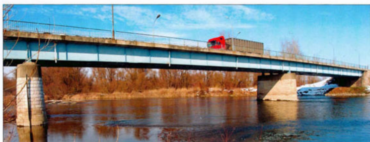
16. ábra A letenyei Mura-híd
