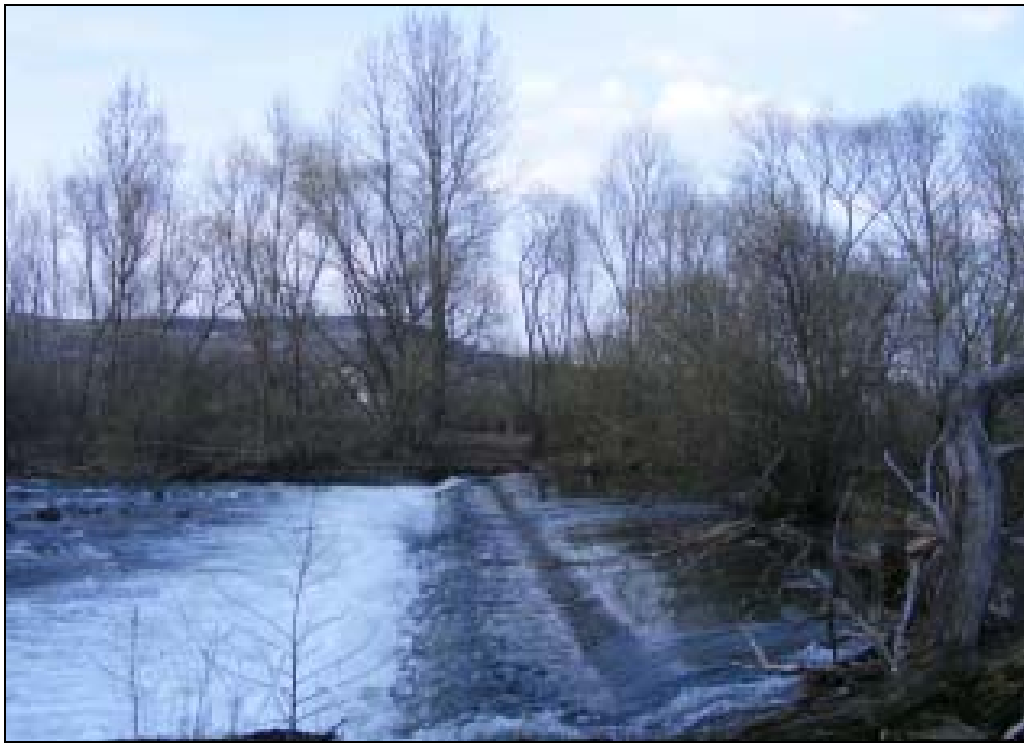
12. ábra A gát hegy felőli oldala növényzettel benőve
