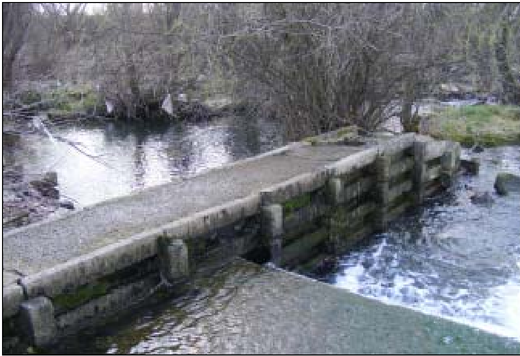
14. ábra A baloldali parttámfal és a bekötő gáttest 25 év után megfelelő, jó állapotban
