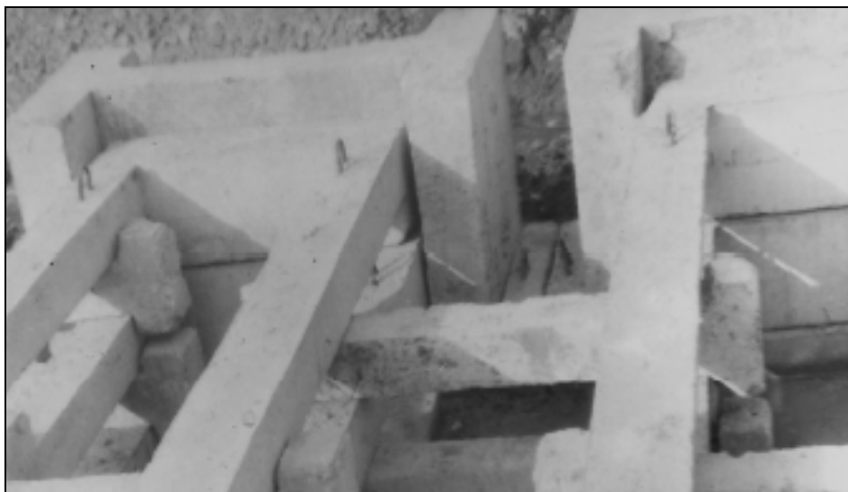
8. ábra A szilárdsági struktúra a mederbeli szerelés közben
