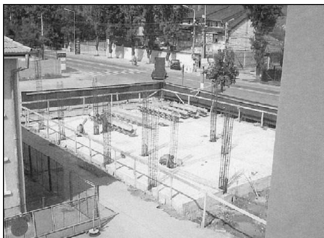
5.ábra A lebetonozott alaplemez
