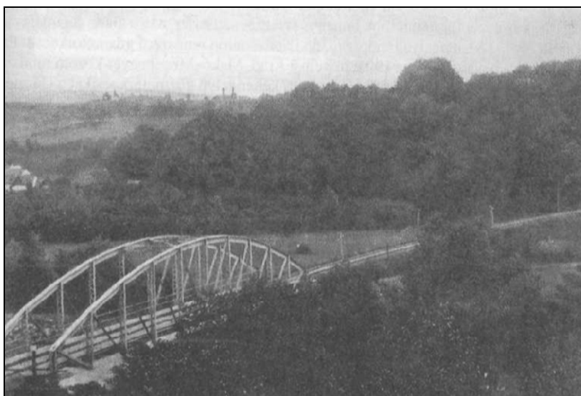
107. ábra Alvácza-Brád közötti Fehér-Körös-híd fényképe
