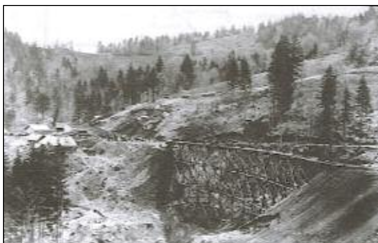
87. ábra A felsőcsapjai völgyhid építése
