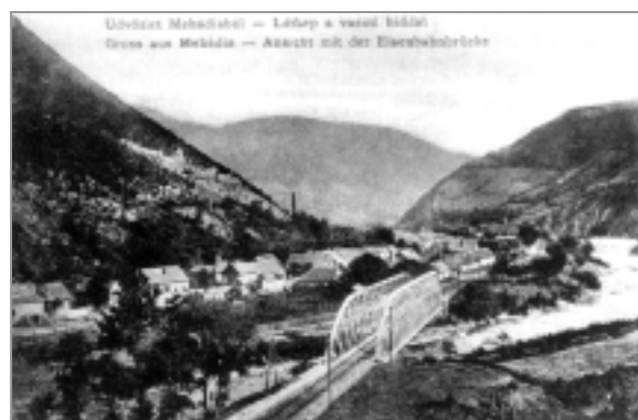
67. ábra A 40 m-es Béla-Réka híd fényképe
