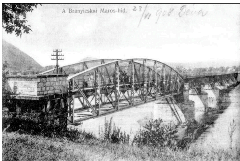
4. ábra A branyicskai Maros-híd vasszerkezetre átépített része
