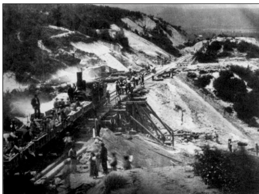
7. ábra A Piski-Petrozsény szárnyvonal pályája építés közben
