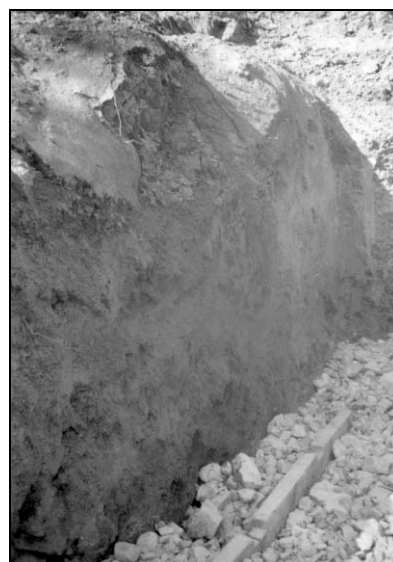
35. ábra A szűrítóborda terméskővel történő kitöltése a föld felületéig
