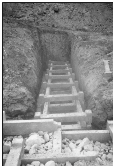
34. ábra A szűrítóborda csatlakozása a támasztószervezethez, szerelés közben
