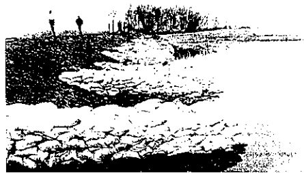
17. ábra A védett oldal támbordái homokzsákokkal. A csúszás megelőzése. A vasalt földtámszerkezeteknél nincs szükség az ilyen jellegű megtámasztásokra
