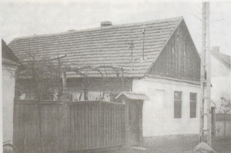
Lakóház és deszkaoromzatú homlokzata
