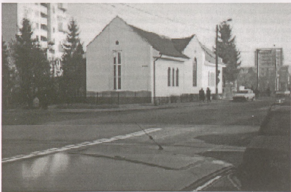
Az újjáépített Pata utcai református templom (1999 december hava)
