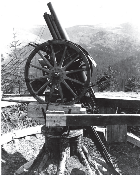
1. kép Az első világháborúban a légi célra történő tüzeléshez szerkesztett állvány (A szerző gyűjtése)
