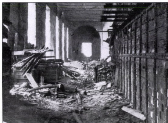
A kiégett második emeleti Ásványtár The burnt out Mineral Collection on the second floor
