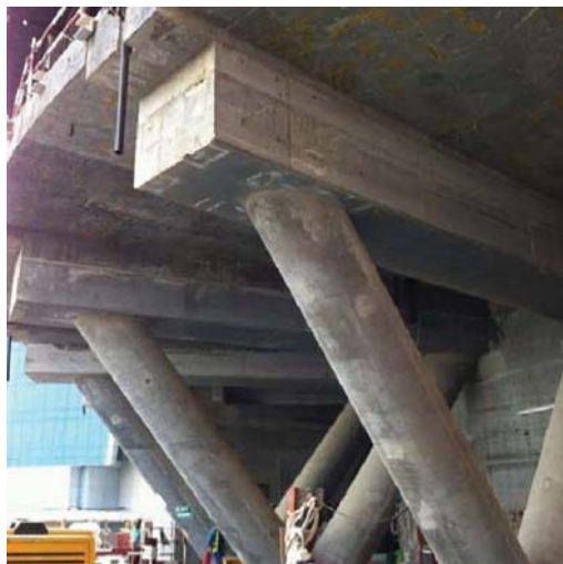
Fig. 5. V-shaped columns of Regent Pearl Hotel located in U.A.E. [16] 5. ábra V-alakú pillérek a Regent Pearl Hotel tartószerkezetében [16]
