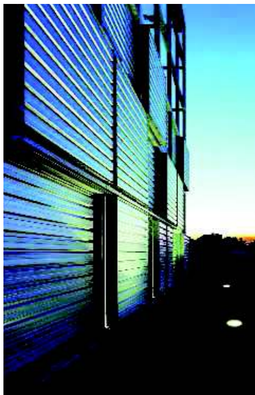
A homlokzati lemezelt elemeket három eltérő mélységben rögzítették a mozgalmos hatás elérése érdekében
