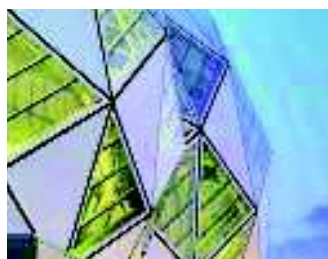
A helyszíni méretre szabással és a körkeresztmetszetű vázszelvényekbe való beépítéssel a kivitelező minőségi munkát végzett
