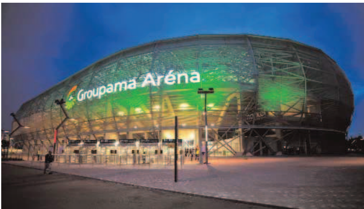
Az acélszerkezet mögött felsejlik a vasbeton váz
