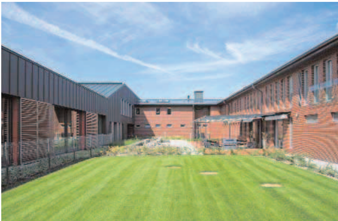
Az új épület csatlakozása a meglévőhöz az északi udvar felől
