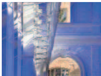
A lecsupaszított téglafalak elé függesztett dekoratív alumínium- szerkezet
