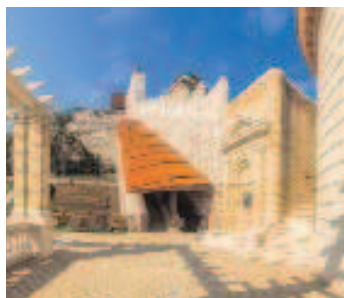
A Déli kortinafal mellé – a Vízhordó folyosó tetjére – húzott húzott új lépcső. Az első elképzelések szerint a mozgólépcső került volna kívülre, hogy arról jobban lehessen élvezni a kertekre nyíló kilátást, csakhogy aléptítménye Zsigmond-kori töredékeket érintett volna, és ezek megbontásához nem járult hozzá a műemlékvédelem
