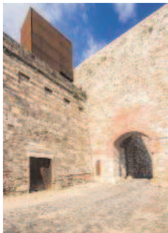
Lifttorony az akadálymentes közlekedésért a Déli kortinafal felső zártudvari pengéfalára
