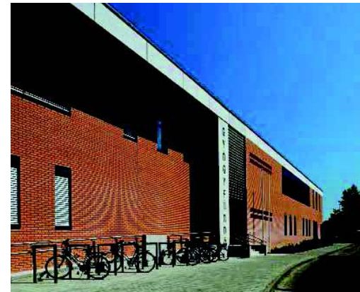
Városfalként funkcionáló déli homlokzat a bejáratnál
