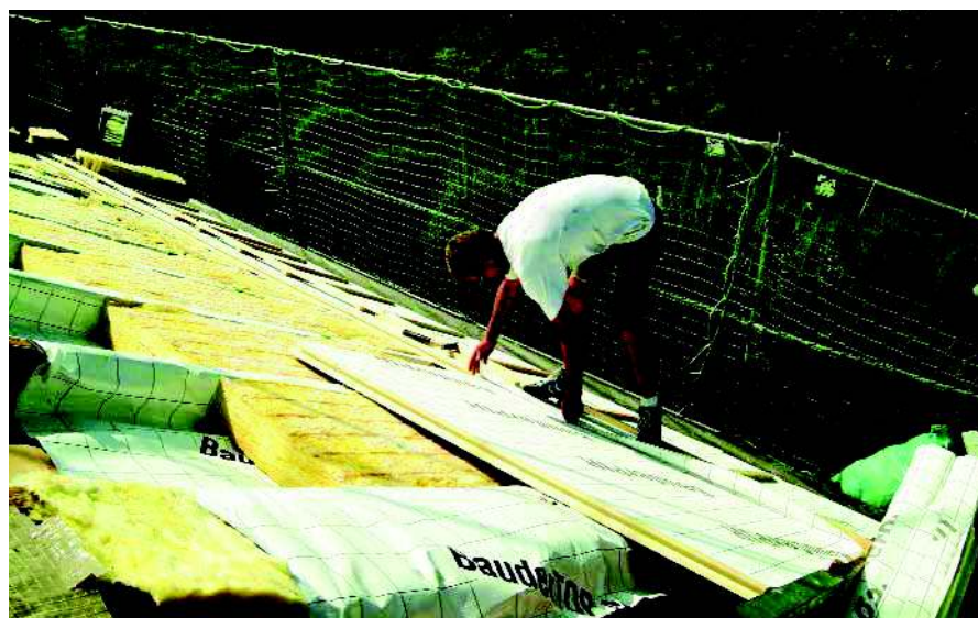
[1] Szarufák feletti rendszer fektetése
