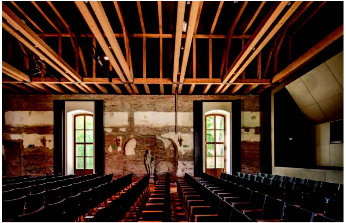
Színházterem. Szemben a kert, jobbra a díszpáholy és a műszaki központ. A fiókváltó gerenda jelzi az egykori közlekedő falát
