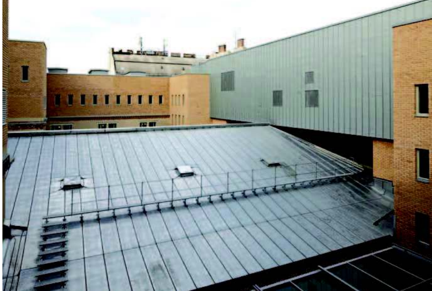
Homogén téglarchitektúra és Rheinzink burkolatos gépészeti tér – a tetőszint udvarra néző homlokzatainak kortárs átépítése
