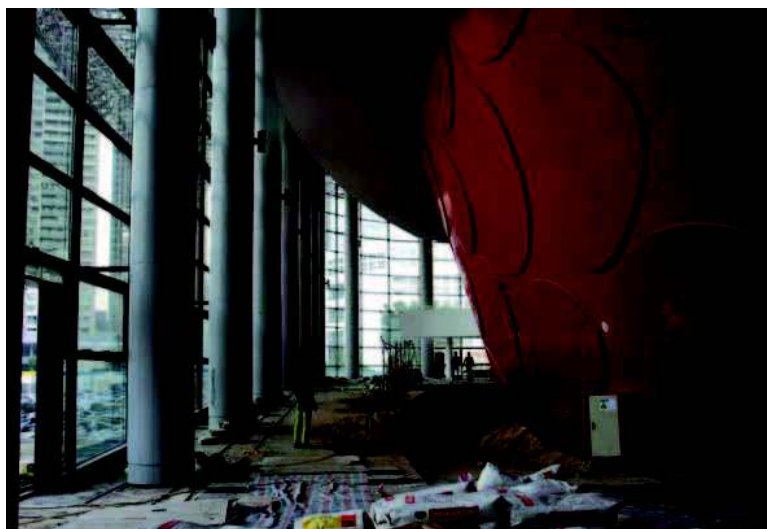
A kulturális épületbe belépve fokozatosan táru fel a maszkok által uralt előcsarnoki tér (látványterv és építés közbeni állapot)
