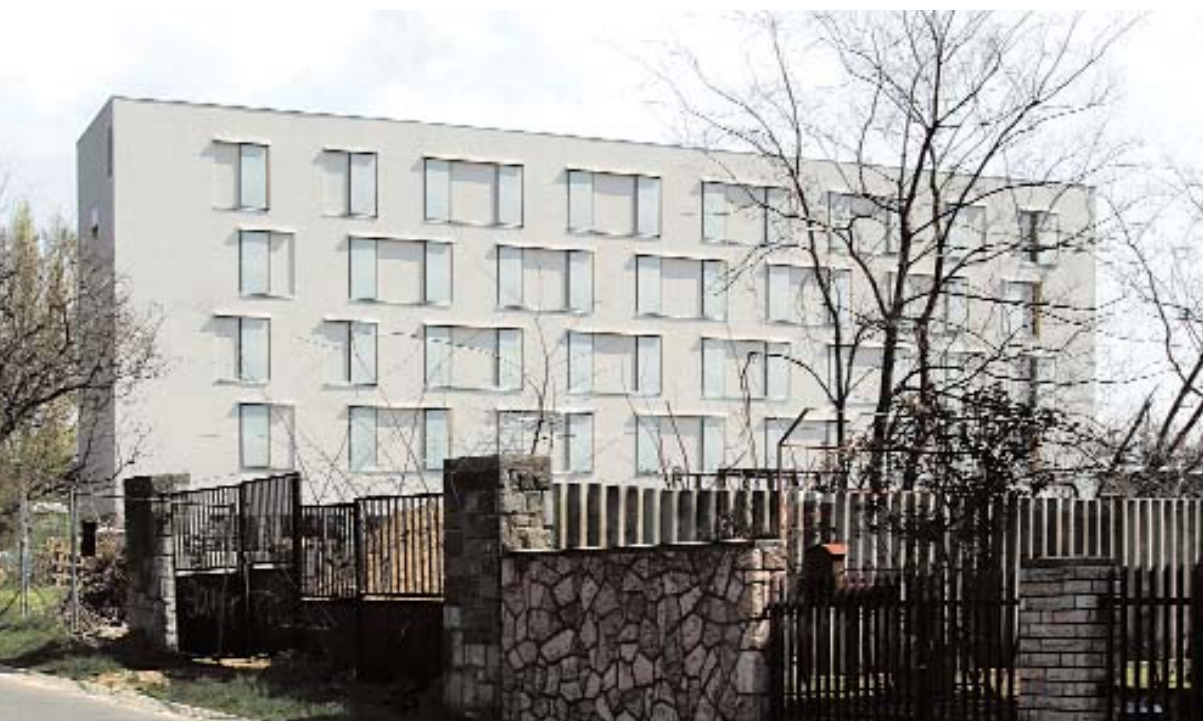
Nézet a fő megközelítés irányából, a kerítés mögött az oktatópálya. A lakószárny az itt álló egykori kollégiumi épület helyén épült
