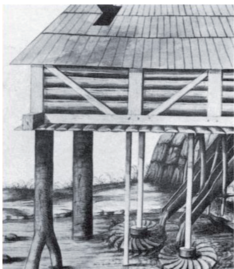
3. kép Kétkerekű kanalas patakmalom Bulgáriában INALCIK, 2001, 299. (43. illusztráció)
