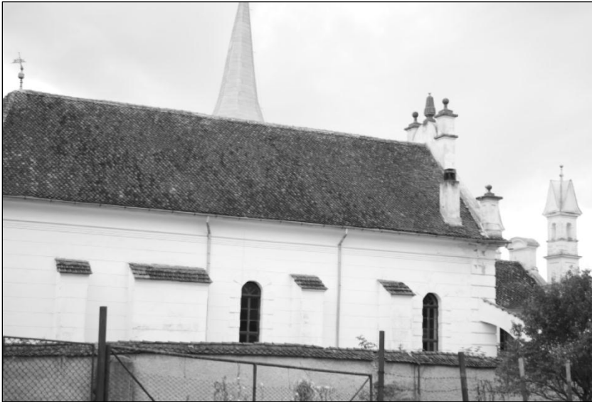
3. kép. A felújított középajtai református templom (Fotó KJA, 2013)
